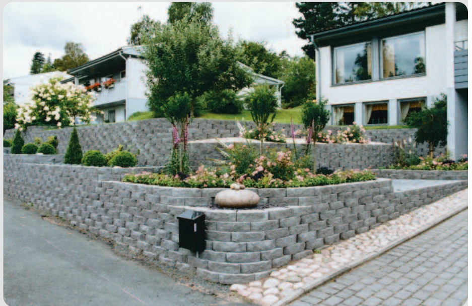
Pågående terrassbyggnation med Windsor terrakotta. Mellan näst översta och 3:e skiftet på den nedre muren ligger ett Geonät fastklämt. Detta går in under den övre muren. Vid den övre muren ligger ett Geonät mitt i muren.
