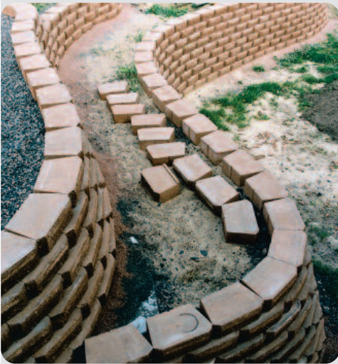
Pågående terrassbyggnation med Windsor terrakotta. Mellan näst översta och 3:e skiftet på den nedre muren ligger ett Geonät fastklämt. Detta går in under den övre muren. Vid den övre muren ligger ett Geonät mitt i muren.
